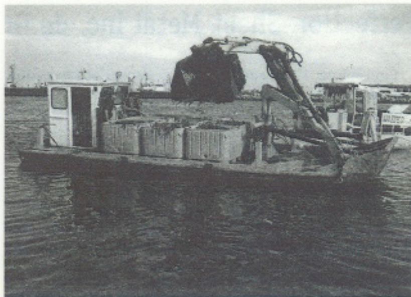
Cette photo a été prise lors des travaux effectués à Lamèque.
